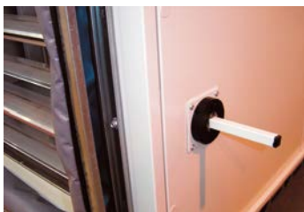
Externe bediening van binnenliggende klep
