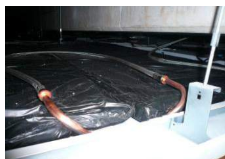
Raccordement en série de plusieurs panneaux
