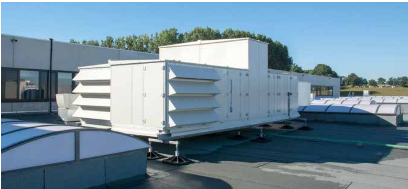
Centrales de traitement d'air modulaires CAIRplus avec roue thermique pour la récupération de chaleur.
