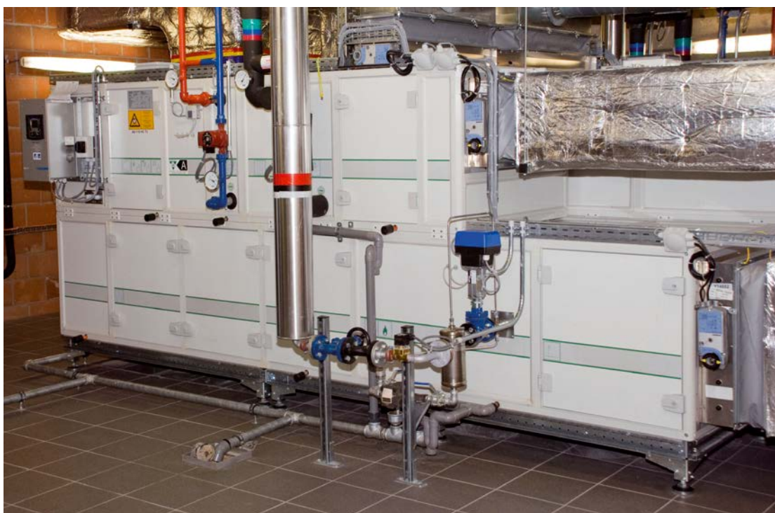
Centrale de traitement CAIRplus® en version hygiène répondant aux exigences les plus strictes sur le plan de la maintenance, de l'entretien et de l'hygiène
