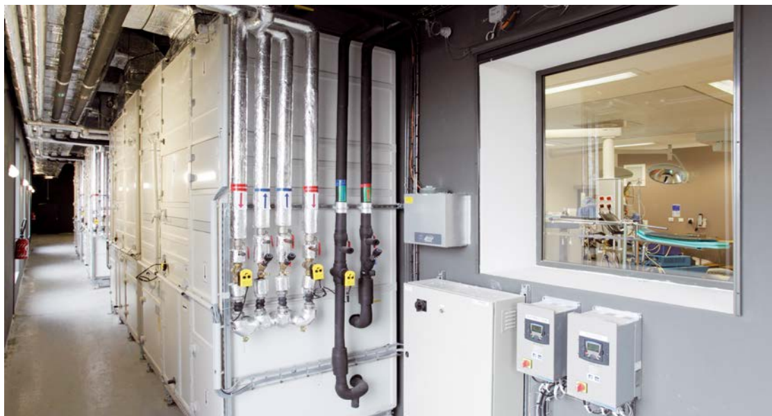
Centrale de traitement CAIRplus® en version verticale installée dans un bloc opératoire
