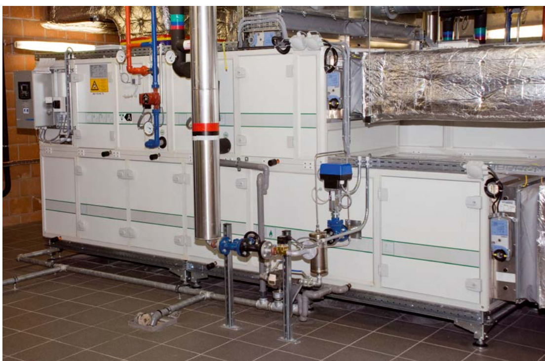
Luchtgroep CAIR plus^{\circ} in hygiëne uitvoering die beantwoordt aan de meest strenge eisen op het vlak van onderhoud en hygiëne
