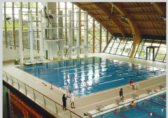
Piscine olympique de Funchal, Portugal CAIRFricostar centrale spéciale avec refroidisseur et récupérateur de chaleur multi-niveaux.
