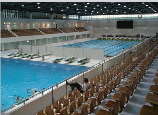
Piscine SSE à Europasportpark, Berlin CAIRFricostar avec récupérateur de chaleur.
