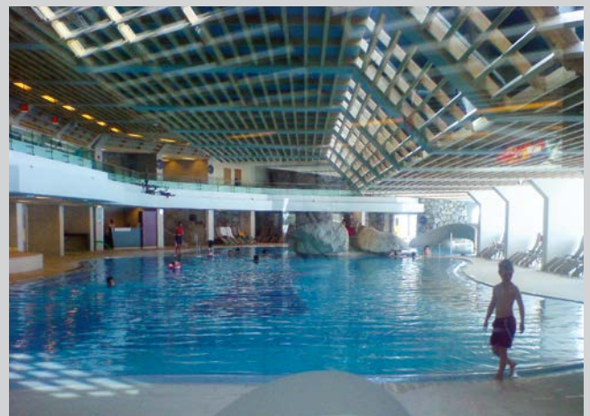
Piscine olympique, Seefeld, Autriche CAIRFricostar avec récupérateur de chaleur, pompe à chaleur et intégration dans la gestion technique du bâtiment.
